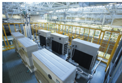
ライン上部の架台に設置したヒートポンプユニット
