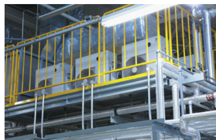
ライン上部の架台に設置したヒートポンプユニット
